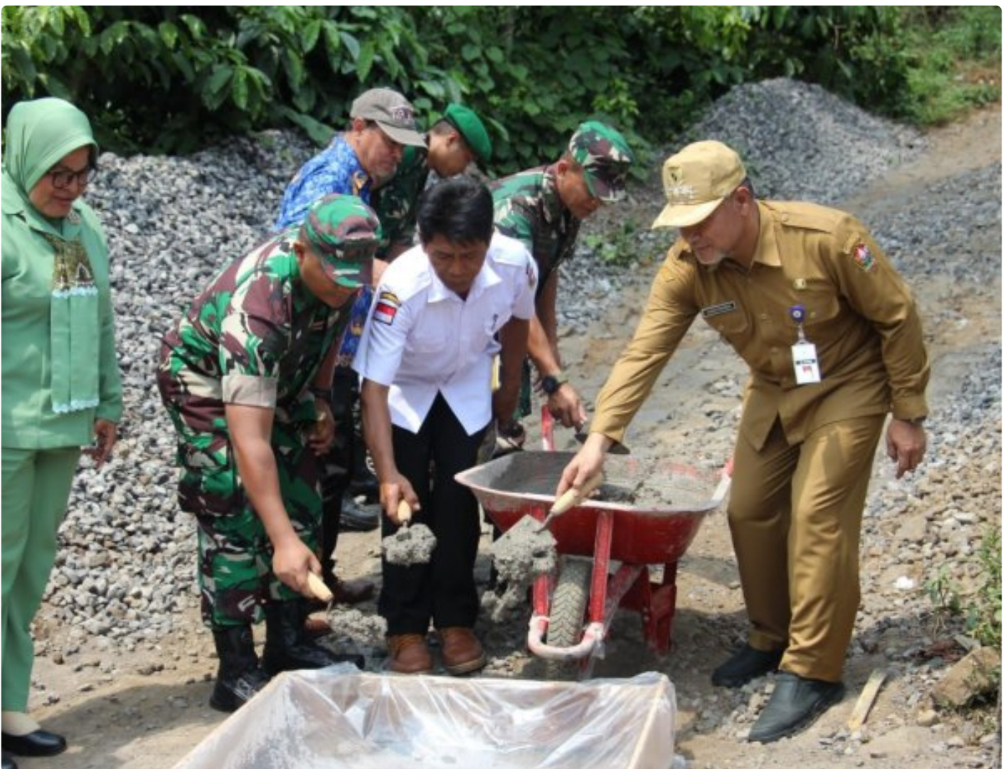
Simbolis Pengecoran Pertama Betonisasi
