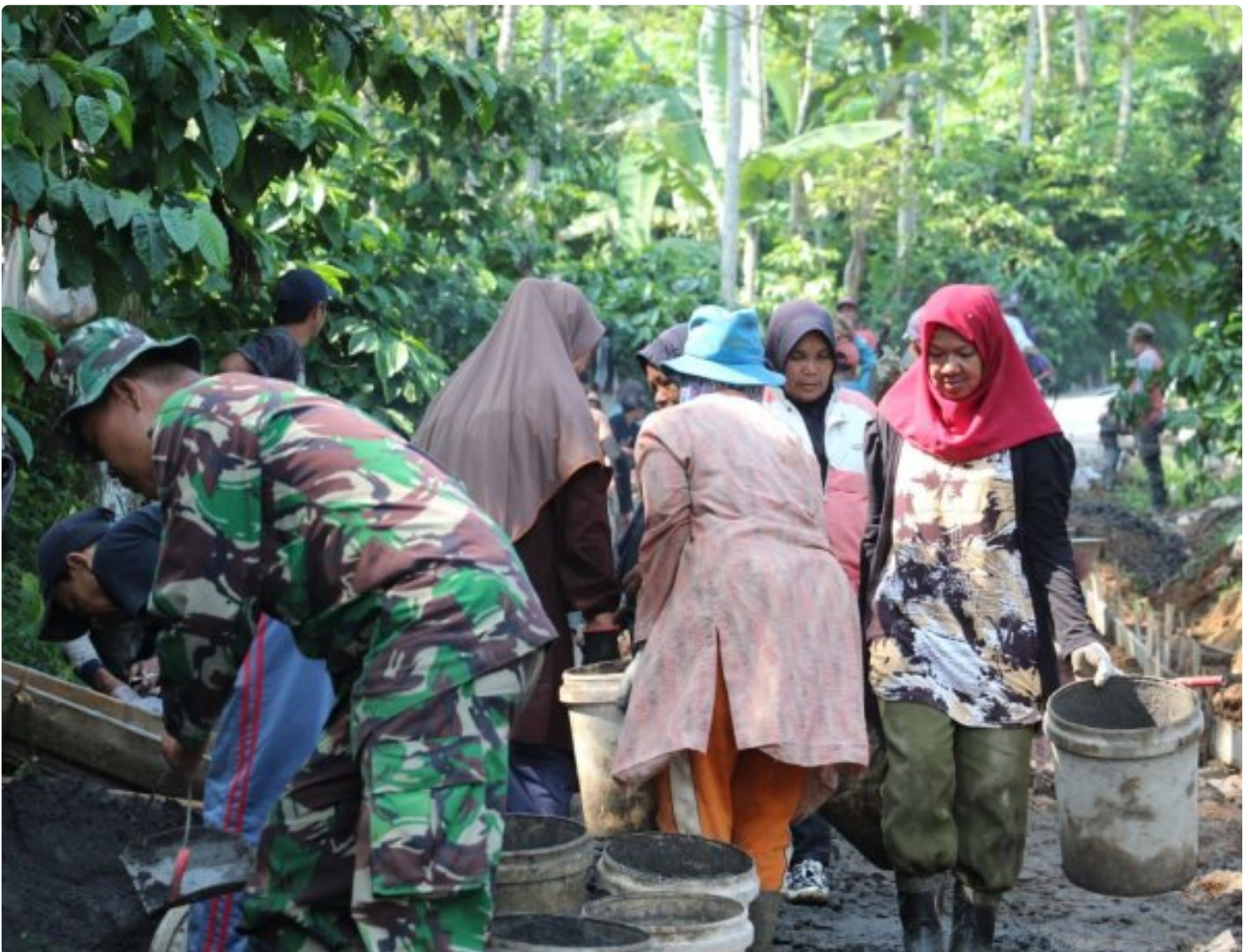
Ibu Ibu Bantu Percepat Pembangunan TMMD
