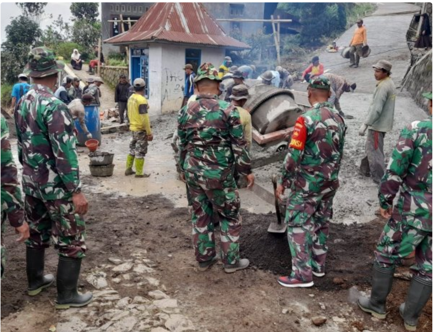
kegiatan fisik pengecoran jalan program TNI Manunggal Membangun Desa (TMMMD)
